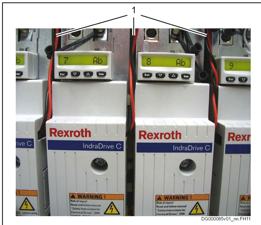
1 Leitungen zur Steuerspannungsversorgung Abb.5-14: Steuerspannungsversorgung an X13
