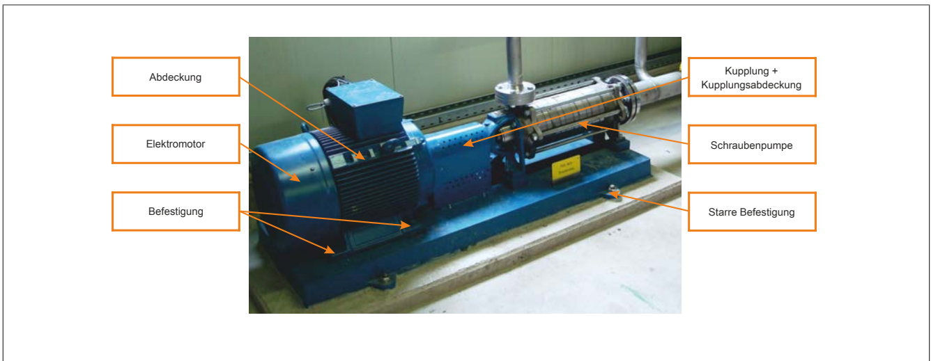
Abbildung 325: Aufbau eines Pumpenantriebs
